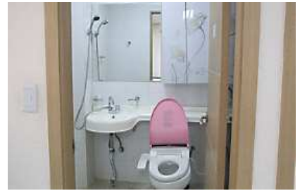
숙소내 욕실 (비데 설치)
